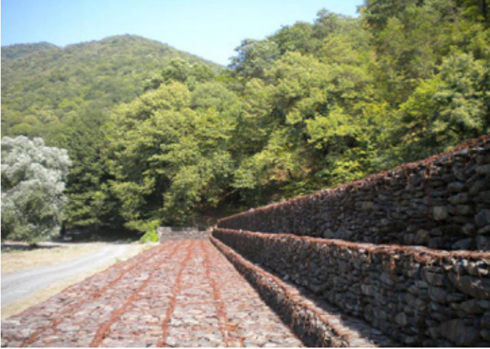
სურ. 4.3.3. ნაპირდაცვითი გაბიონი მდ. დურუჯის სანაპიროზე
