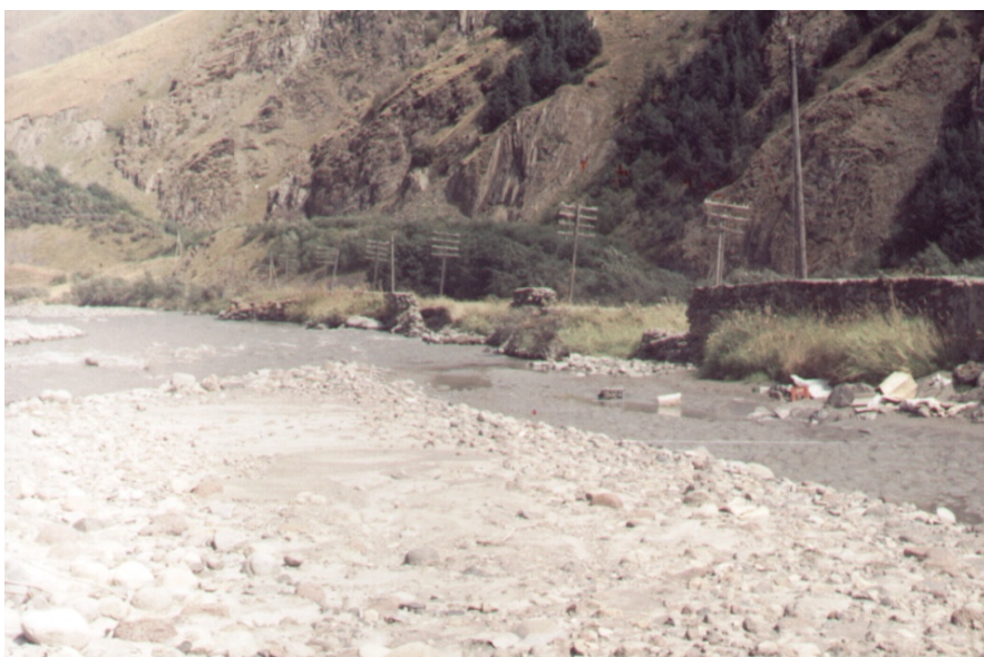
სურ. №51 სოფ. აჩხოთსა და დაბა სტეფანწმინდას შორის მდ. თერგი აწარმოებს მარჯვენა ნაპირის გარეცხვას და საშიშროებას უქმნის სამხედრო გზას
