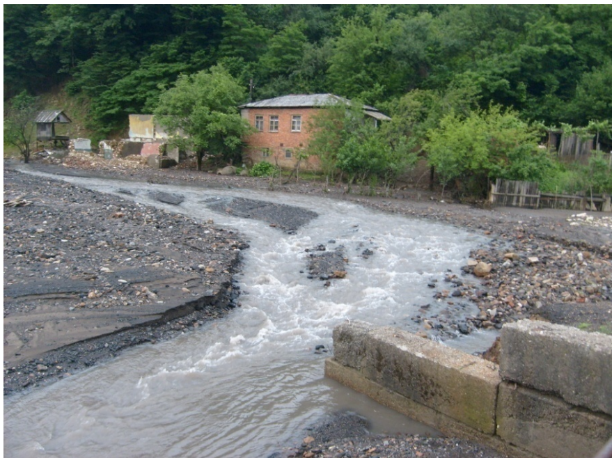
სურ.№31 მდ. ტყიბულას გვერდითი ეროზიის შედეგად დაზიანებული სახლი და ნაპირდამცავი კონსტრუქცია.
