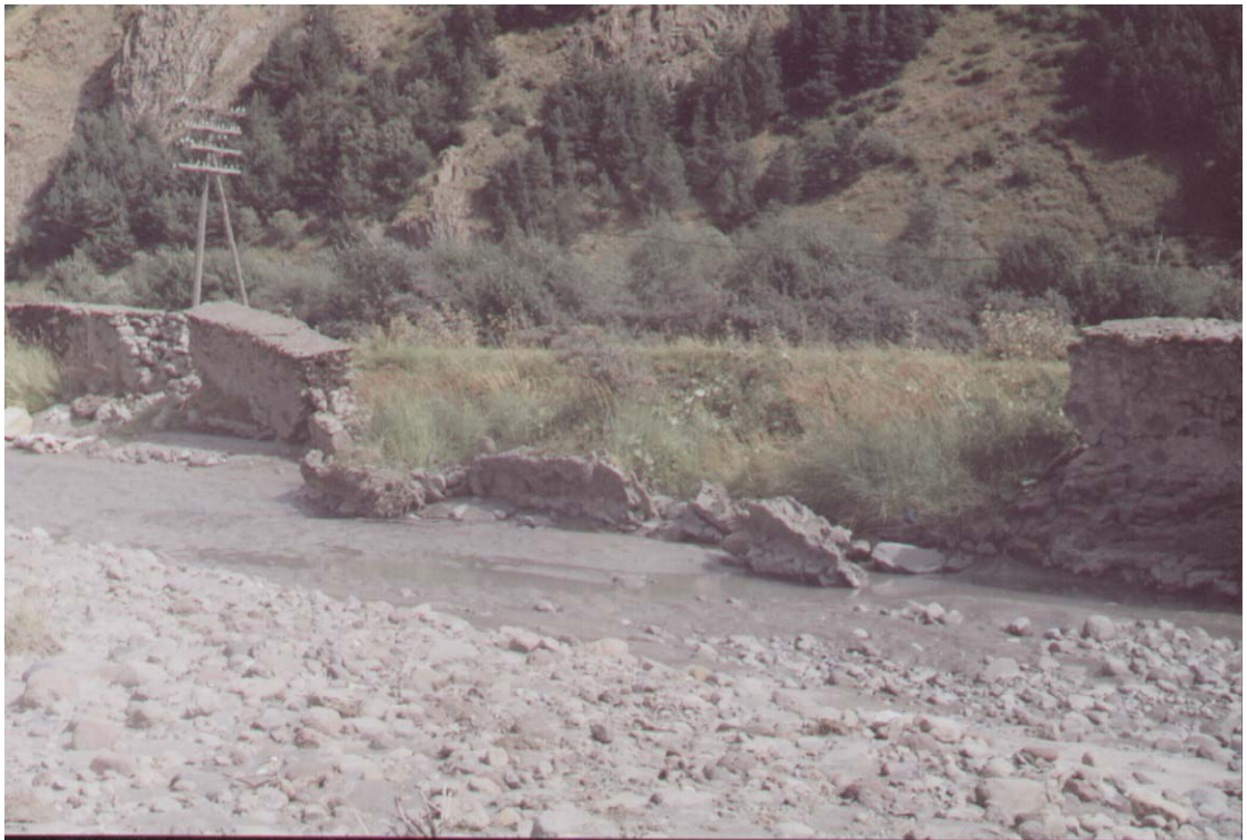
სურ. №97. მდ. თერგის მიერ გარეცხილი და დაზიანებული მარჯვენა ნაპირისამაგრი.
