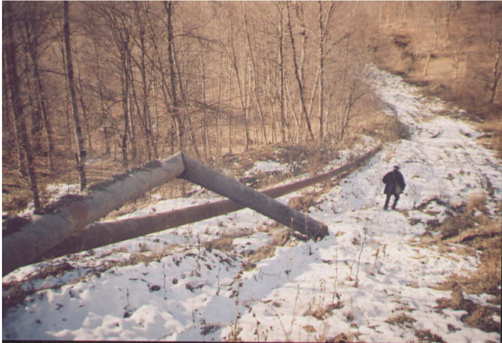
სურ. №4. კახეთის გაზმომარაგების მილსადენი ახმეტა-თიანეთის მონაკვეთზე მეწყერული პროცესებით დაზიანებული გაზსადენის მილი.
