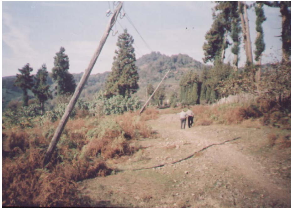
სურ №32. სოფ. მამათი, დაზიანებული ელექტრო გადამცემი სახები.
