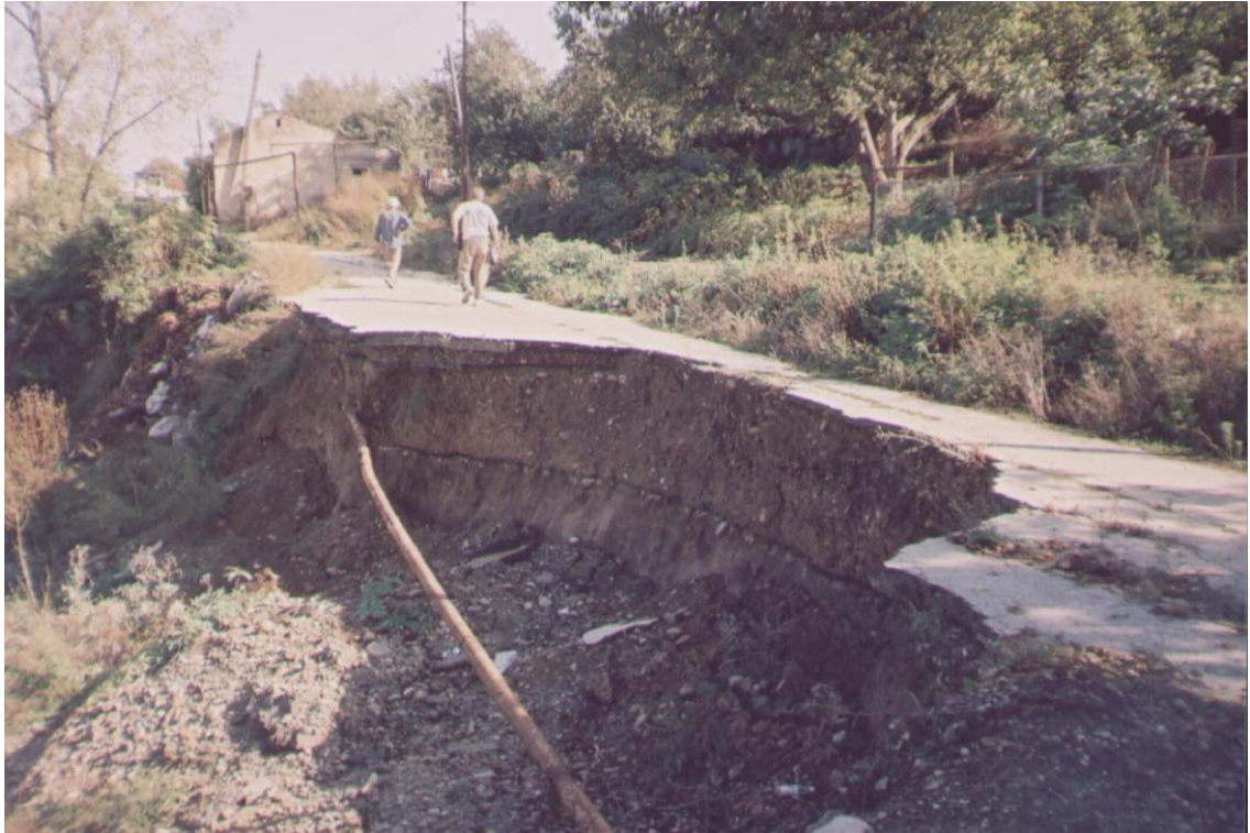
სურ №106. ქ. სიღნაღი, „სპორტკომპლექსის“ მიმდებარე ტერიტორია, გააქტიურებული მეწყერით წადებული საავტომობილო გზის მონაკვეთი.
