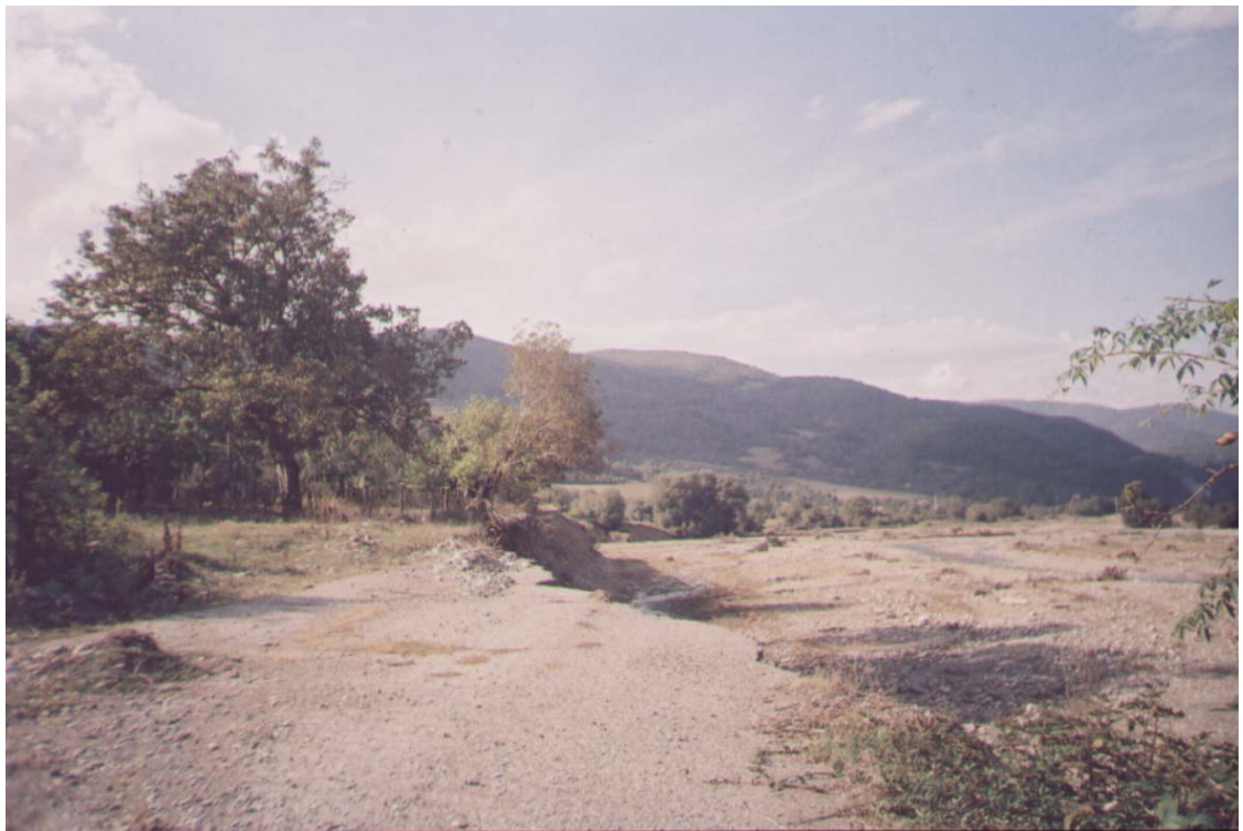
სურ №101. მდ. ილტოს მარჯვენა ნაპირის გარეცხვის შედეგად საავტომობილო გზის განადგურებული მონაკვეთი სოფ. ნაღუქნართან
