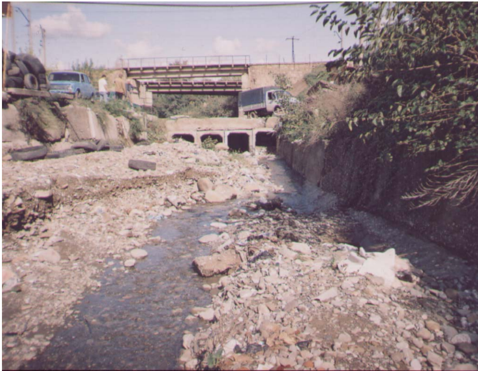
სურ №105. ქ. გურჯაანი, მოძველებული კონსტრუქციის 4 სექციად დაყოფილი ნაკადგამტარი
