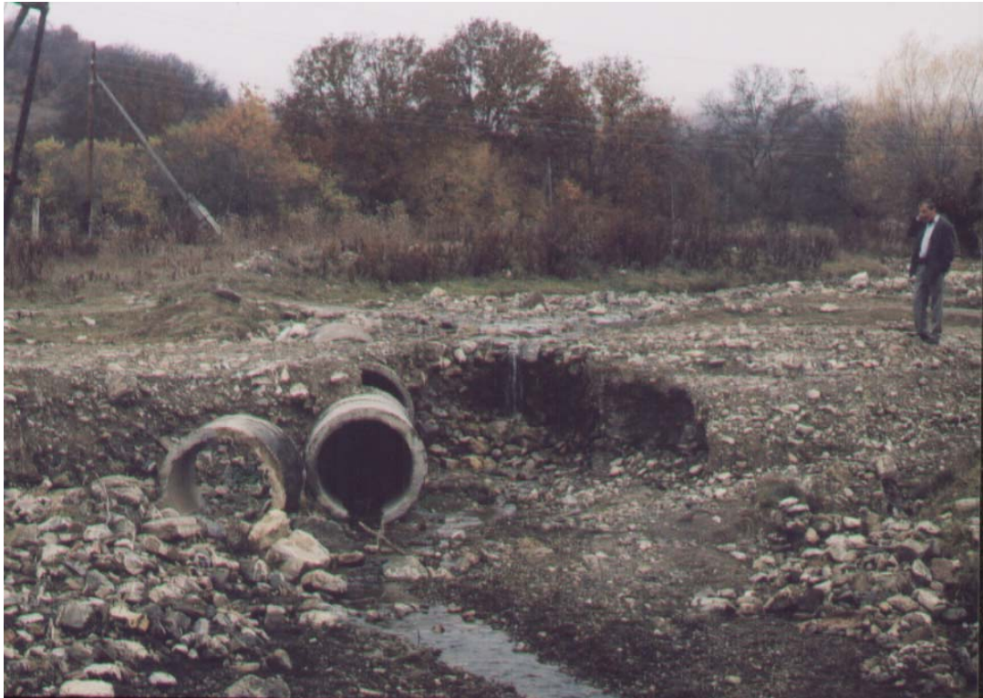
სურ. №92. სოფ. ჯიჯეთი, დაზიანებული მილხიდი.
