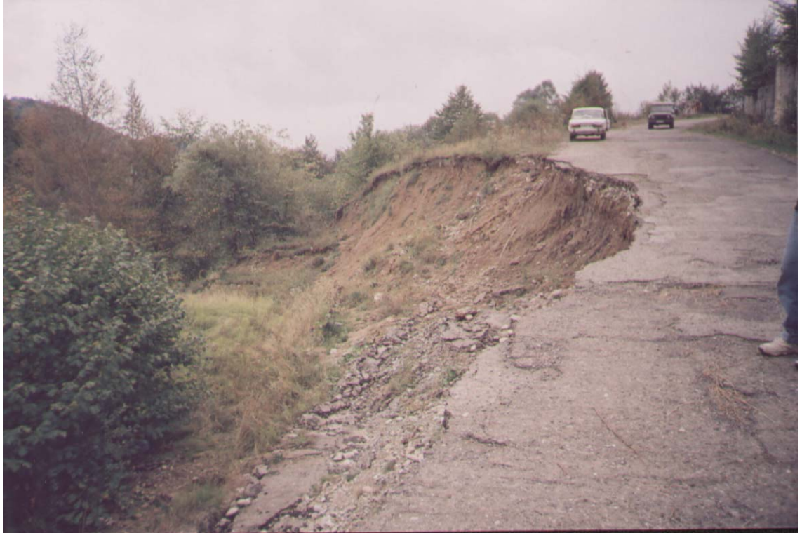
სურ. №99. მეწყერით დაზიანებული თელავი-გომბორის საავტომობილო გზის მონაკვეთი, სოფ. კობაძეების მახლობლად.
