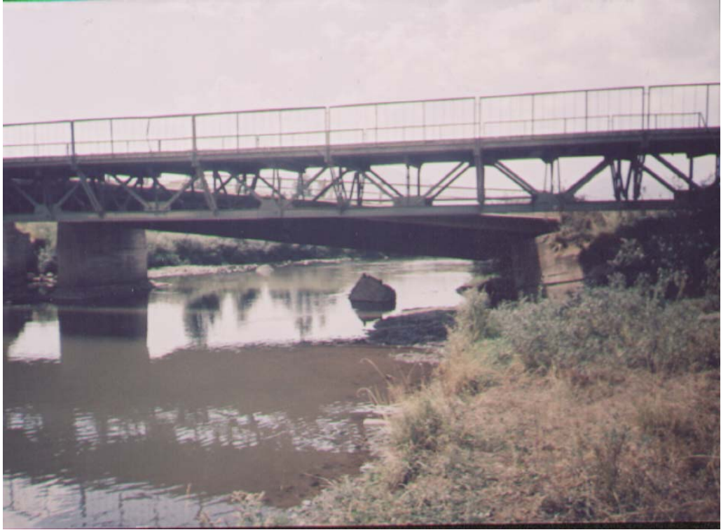
სურ. №108. მდ. ქციას გადაკვეთაზე ნაპირების გარეცხვის შედეგად დაზიანებული ხიდები (სოფ. თიქილისას მიმდებარე ტერიტორია)
