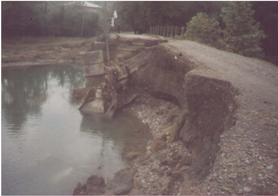
სურ. №37. სოფ. ჩოჩხათი, მდ. შუთის მიერ დაზიანებული სოფლის ცენტრალური გზა და ხიდი
