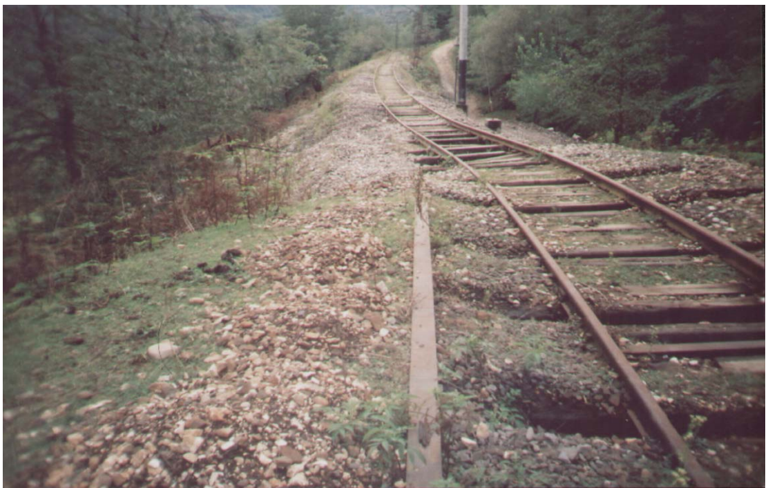
სურ. №54. სოფ. სრესილა. მეწყერის ამოძრავების შედეგად დაზიანებული ქუთაისი-ტყიბულის რკინიგზის მონაკვეთი
