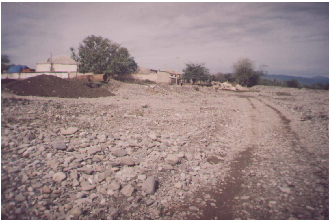
სურ. №86. სოფ. ფერმაში მდ. ქსნის მარჯვენა ნაპირზე მოწყობილი დროებით დამცავი ზვინული (სურათზე მარჯვნივ).
