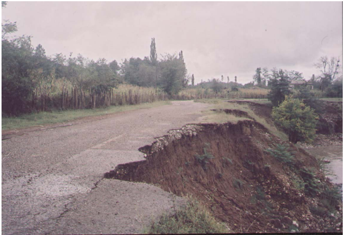
სურ. №27. მდ. ტეხურის გვერდითი ეროზიით დაზიანებული საავტომობილო გზა. მარტვილის რაიონი, სოფ. გურძემი.
