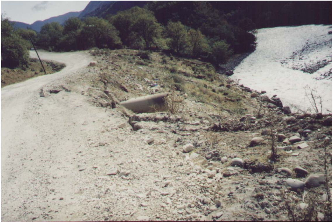
სურ №58. სოფელ წესში ონი-ამბროლაურის საავტომობილო გზის მეწყერით დაზიანებული მონაკვეთი
