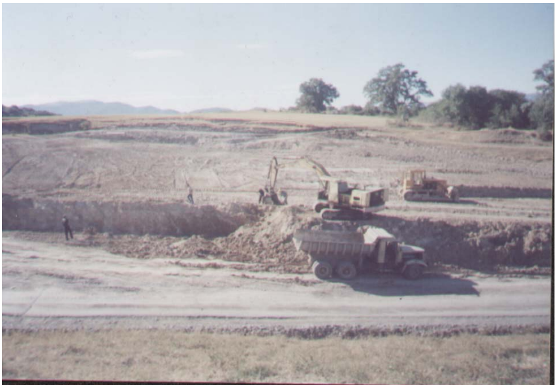
სურ. №111. ფარცხისი-თეთრიწყაროს საავტომობილო გზაზე მიმდინარე მეწყერსაწინააღმდეგო სამუშაოები
