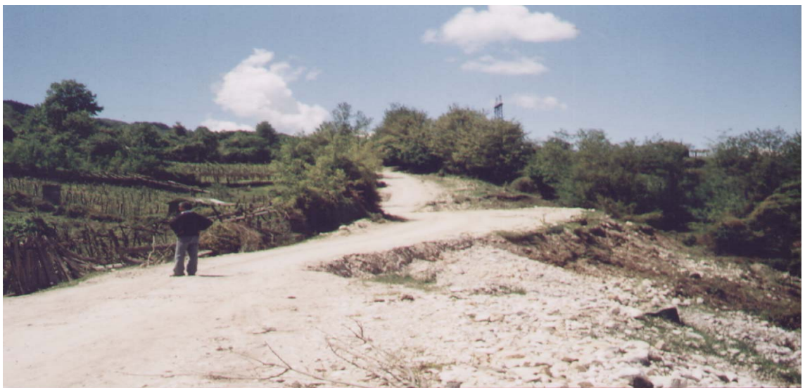
სურ №60. ბუგეული-საკეციას საავტომობილო გზის მეწყრით დაზიანებული მონაკვეთი
