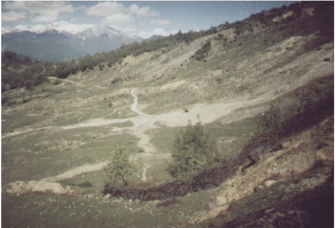
სურ №64. სოფელ აღვის ტერიტორიაზე განვითარებული მეწერული პროცესით დაზიანებული საავტომობილო გზა
