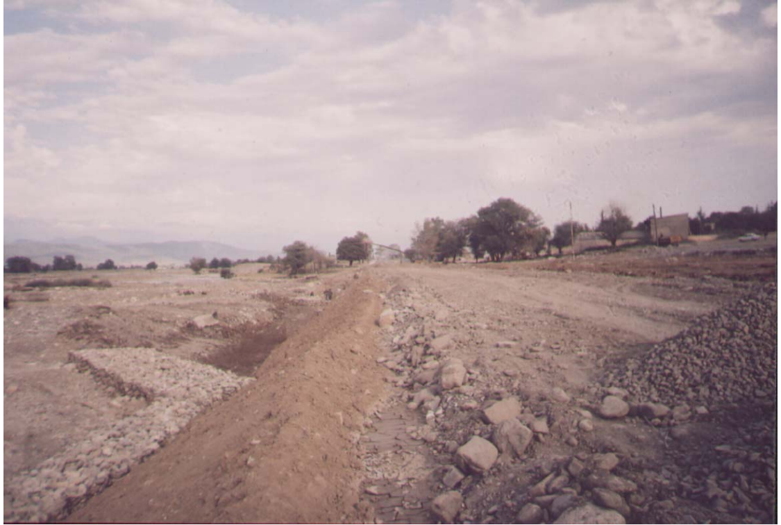
სურ. №100. მიმდინარე ნაპირსამაგრი სამუშაოები „პარკეტის“ ქარხანასთან ჩვენი რეკომენდაციების გათვალისწინებით.
