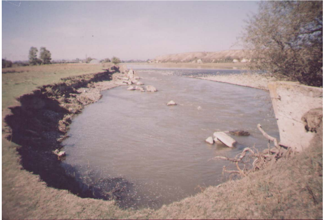
სურ. №79. ერთ-ერთი დანგრეული უბანი ნაპირსამაგრი კედლისა ქ. ქარელთან მდ. მტკვრის მარჯვენა ნაპირზე.
